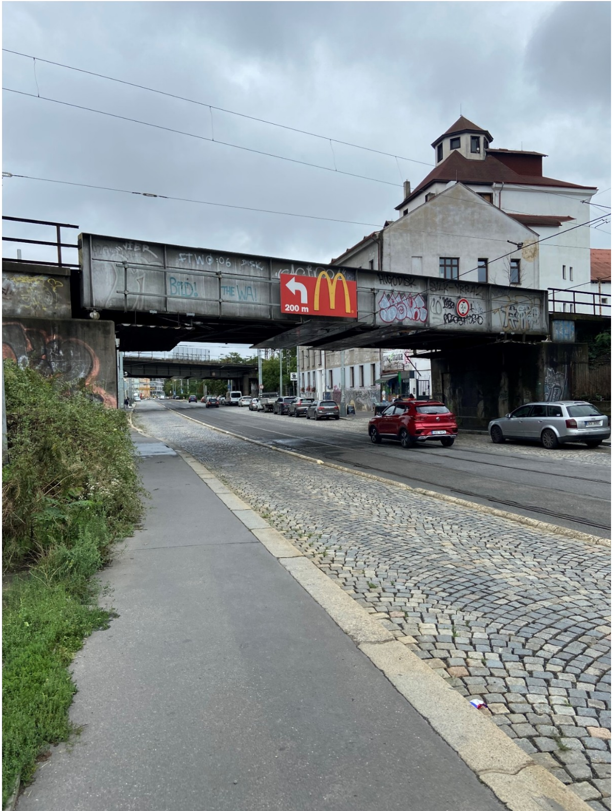
Fotodokumentace ze dne 29.08.2023, místo: konstrukce železničního mostu přes komunikaci v ulici Nádražní, Praha 5.
